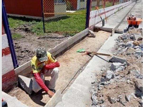
**Construcción de cuneta en la Presa a la altura de las chanchas con dirección a la localidad de la Chehuayito.**
